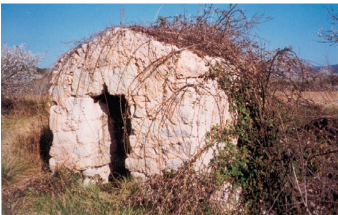
Caseta de regulación de riego Alto Palancia.
